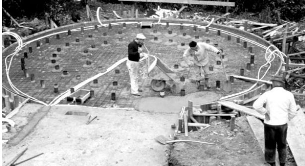
Bau der kreisrunden Bodenplatte mit den Steckhülsen für die drei Sitzringe der Bestuhlung
