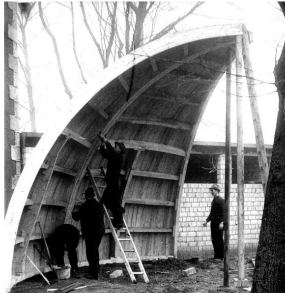
Montage der hölzernen Dachkonstruktion aus einzelnen Kugelschalensegmenten
