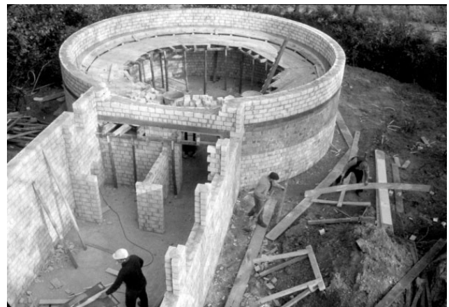
Zwischen Foyer und Rundbau sind die Lichtschleuse (rechts) und der Raum für die Belüftungsanlage erkennbar
