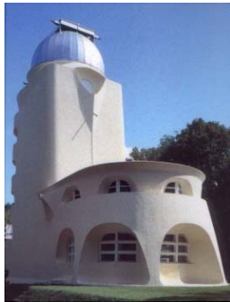
Der Einstein-Turm in Potsdam, ein spezielles Sonnenobservatorium
